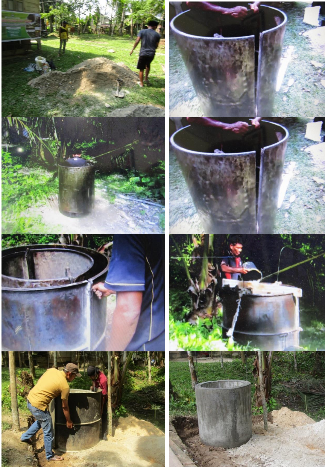
Gambar 3. Proses pembuatan sumur gali untuk masyarakat
